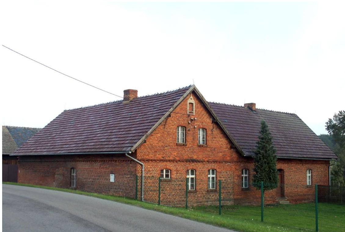
Widok budynku od północnego - zachodu
