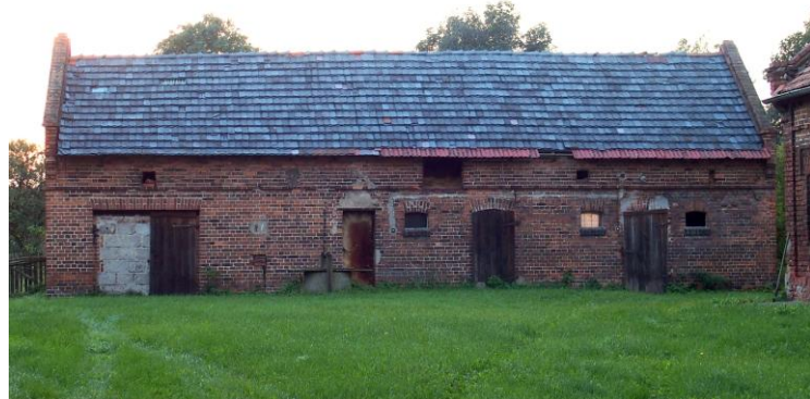
Widok budynku od wschodu
